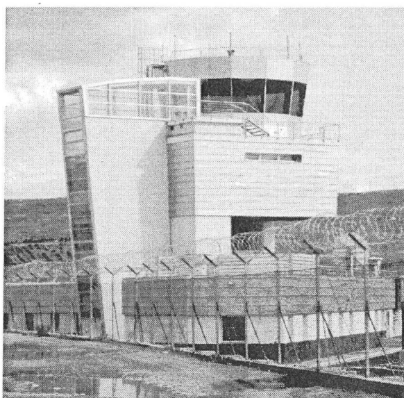
Da oggi la torre di controllo dell'aeroporto è operativa
